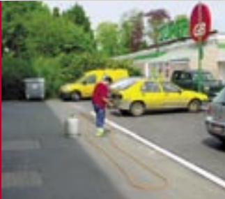
Marquage au sol du parking de la poste à Jodoigne
